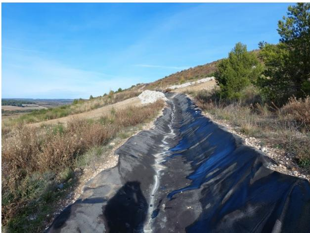
Photo 9 : Descente d'eau avec membrane bitumineuse flanc Ouest (12/12/22)
