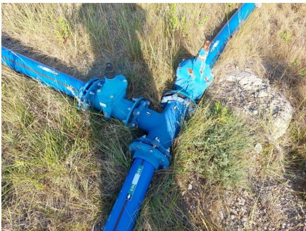
Photo 3 : Jonction des deux nouvelles conduites des drains D1 et D2 (05/07/22)
