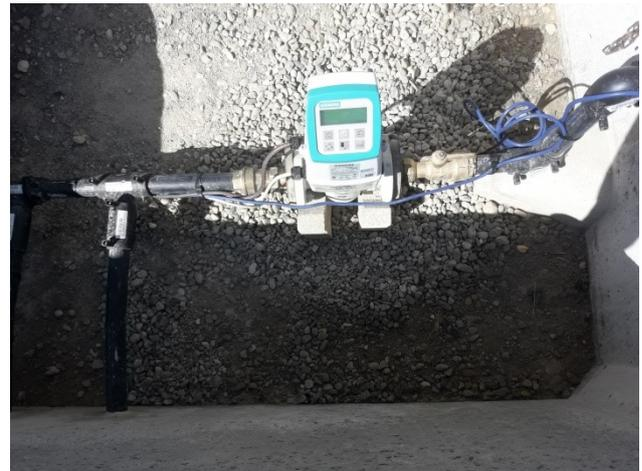
Photo 2 : Compteur centralisé du pompage des 4 puits (19/04/22)
